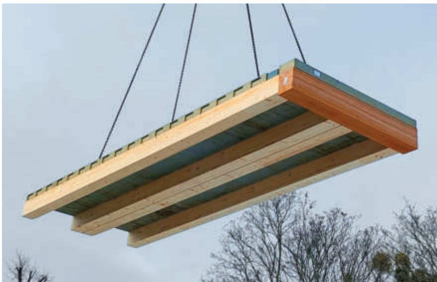
Abbildung 5: Holz-Beton-Verbunddecke mit werkseitigem Aufbeton
