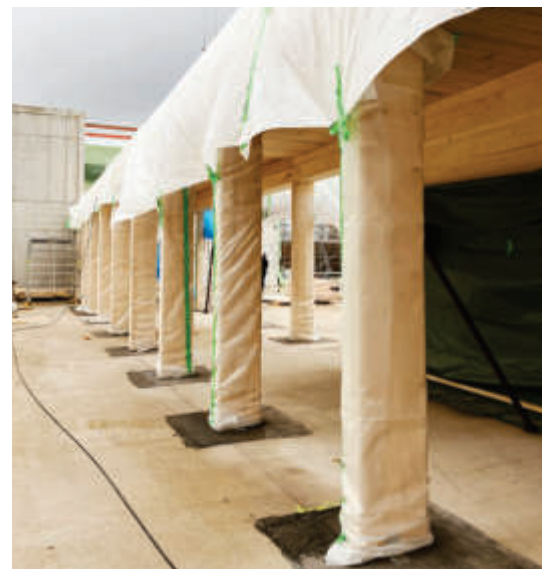
Abbildung 6: Bauteilschutz mittels Folien und Abklebungen
