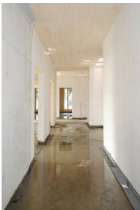
Abbildung 2: Wassereintritt nach einem Regenereignis
